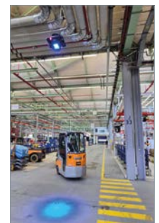
↑ Blauer LED-Spot warnt frühzeitig vor herannahenden Flurförderzeugen
