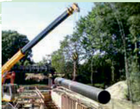
Pipe installation works Rohrlegearbeiten
