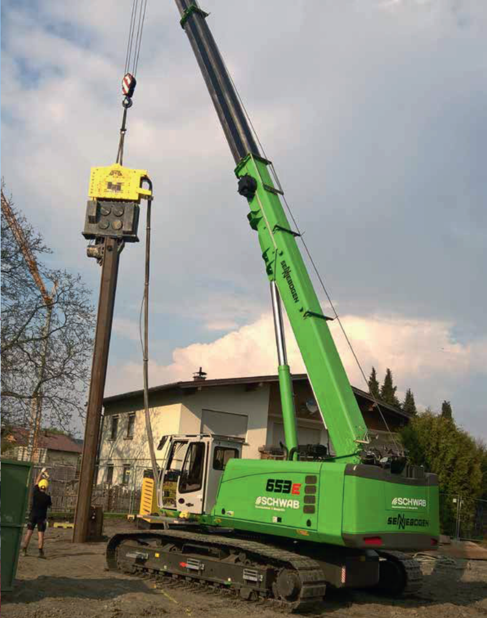
653 R - lift sheet piles safely and reliably with vibrator and bring them into the ground; Germany 653 R - mit Rüttler Spundwände sicher und zuverlässig heben und einbringen in den Boden; Deutschland
