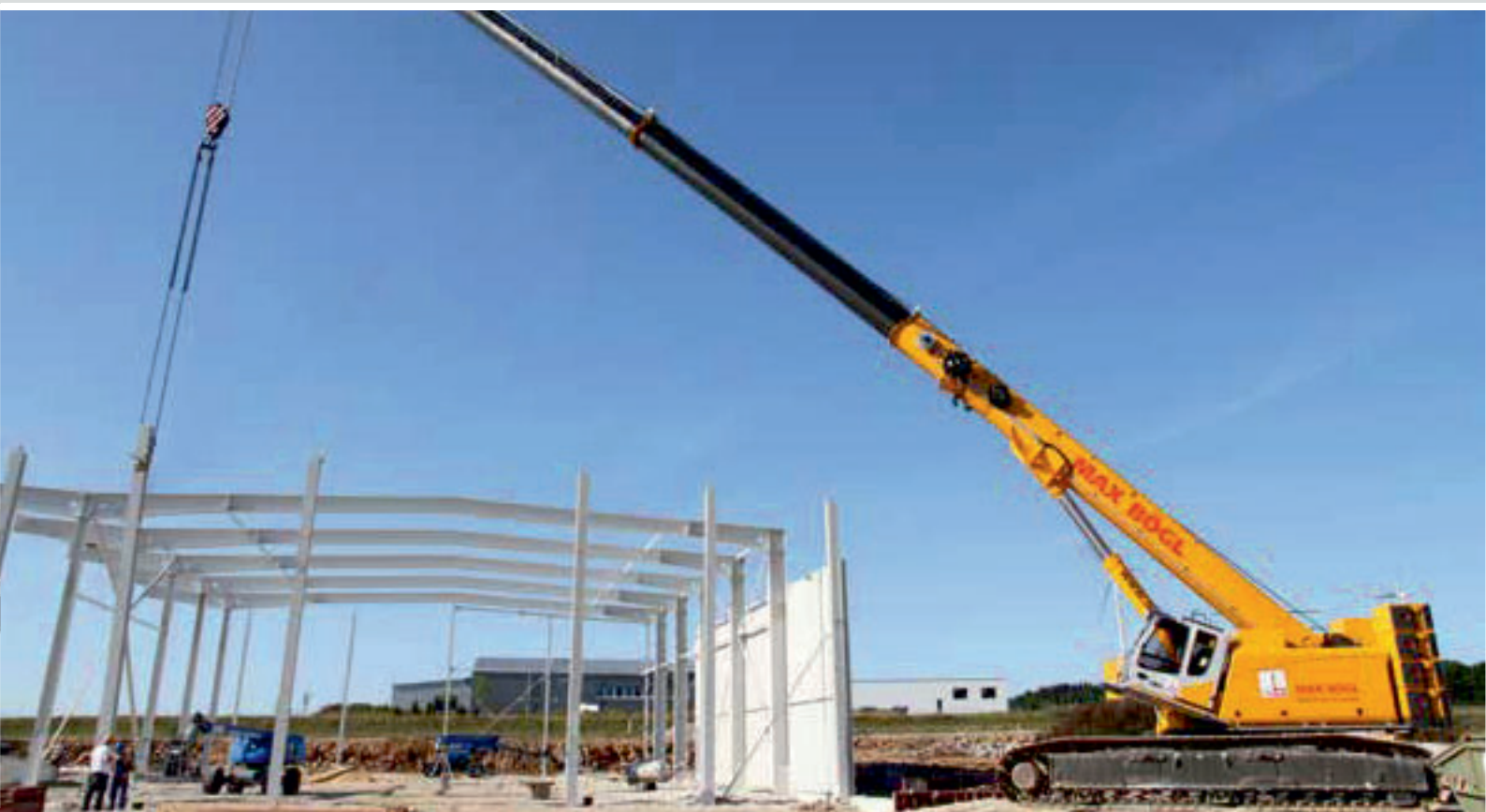
6113 R - secure positioning and setting of concrete piers, even with large working radii 6113 R - Betonpfeiler auch bei großen Arbeitsradien sicher positionieren und setzen
