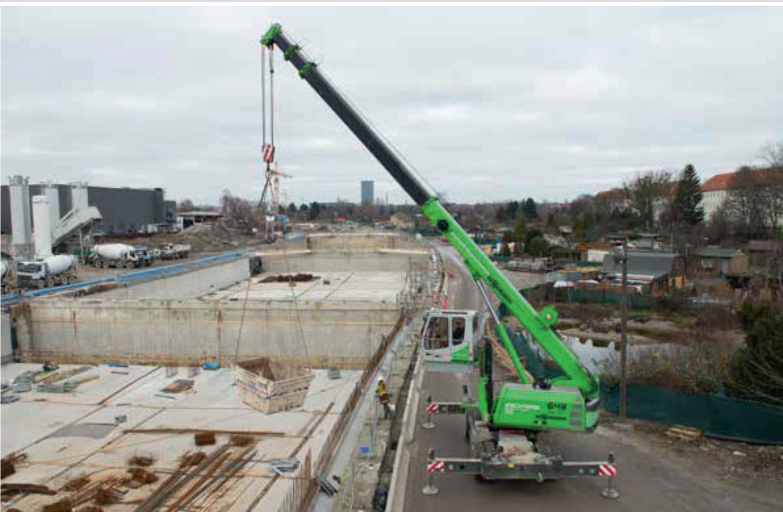
643 M - lifting tasks on construction site with vertical cab adjustment; Germany 643 M - Hebeaufgabe im Tiefbau mit vertikaler Kabinenverstellung; Deutschland
