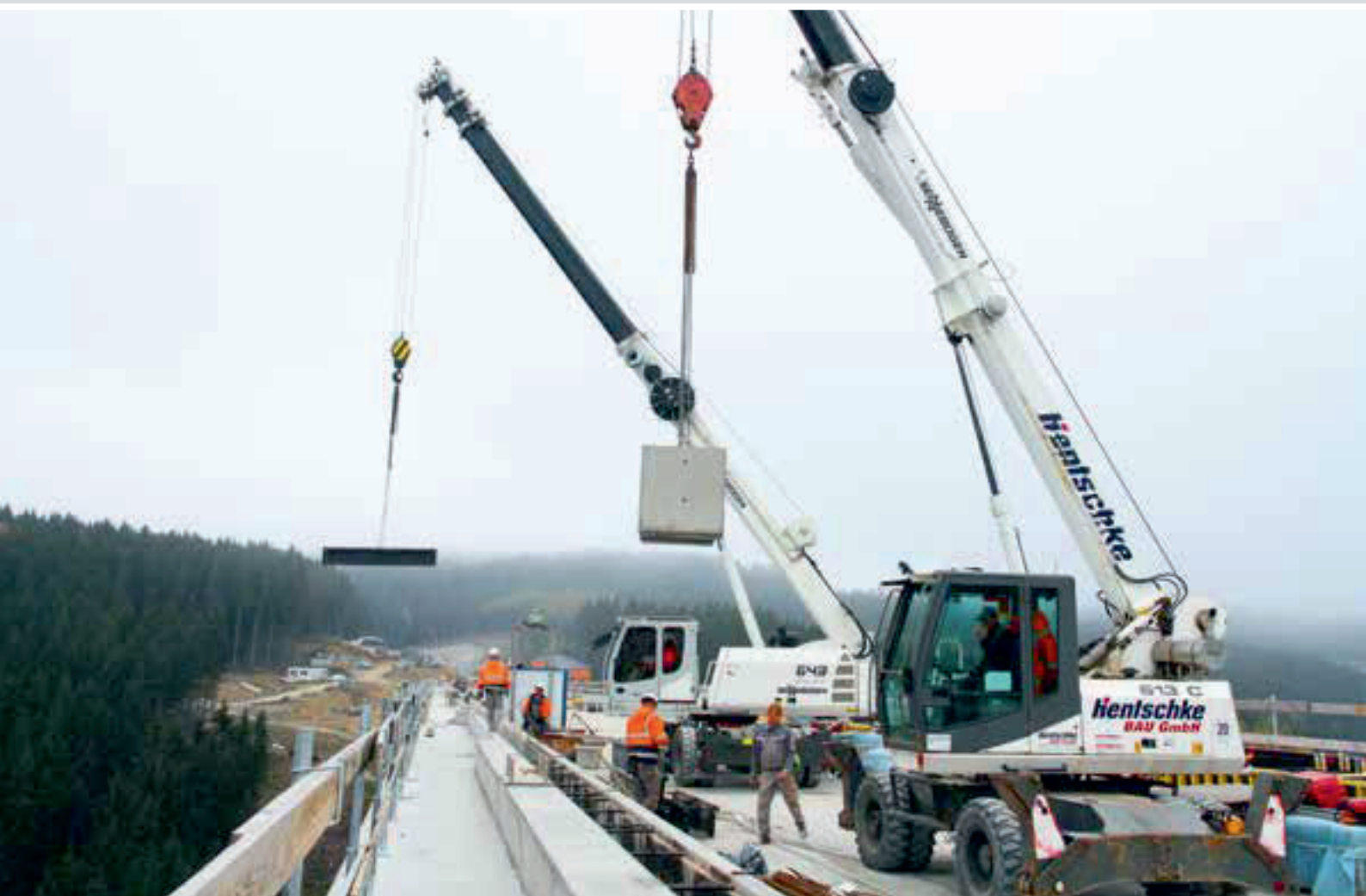
643 M & 613 M – use on bridge construction sites; Germany 643 M & 613 M – Einsatz auf Brückenbaustellen; Deutschland
