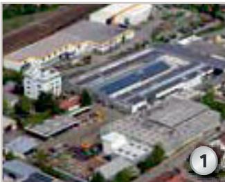
Works 1, Straubing: Company headquarter Werk 1, Straubing: Unternehmenssitz
