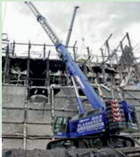
Demolition & Dismantling Abbruch & Rückbau
