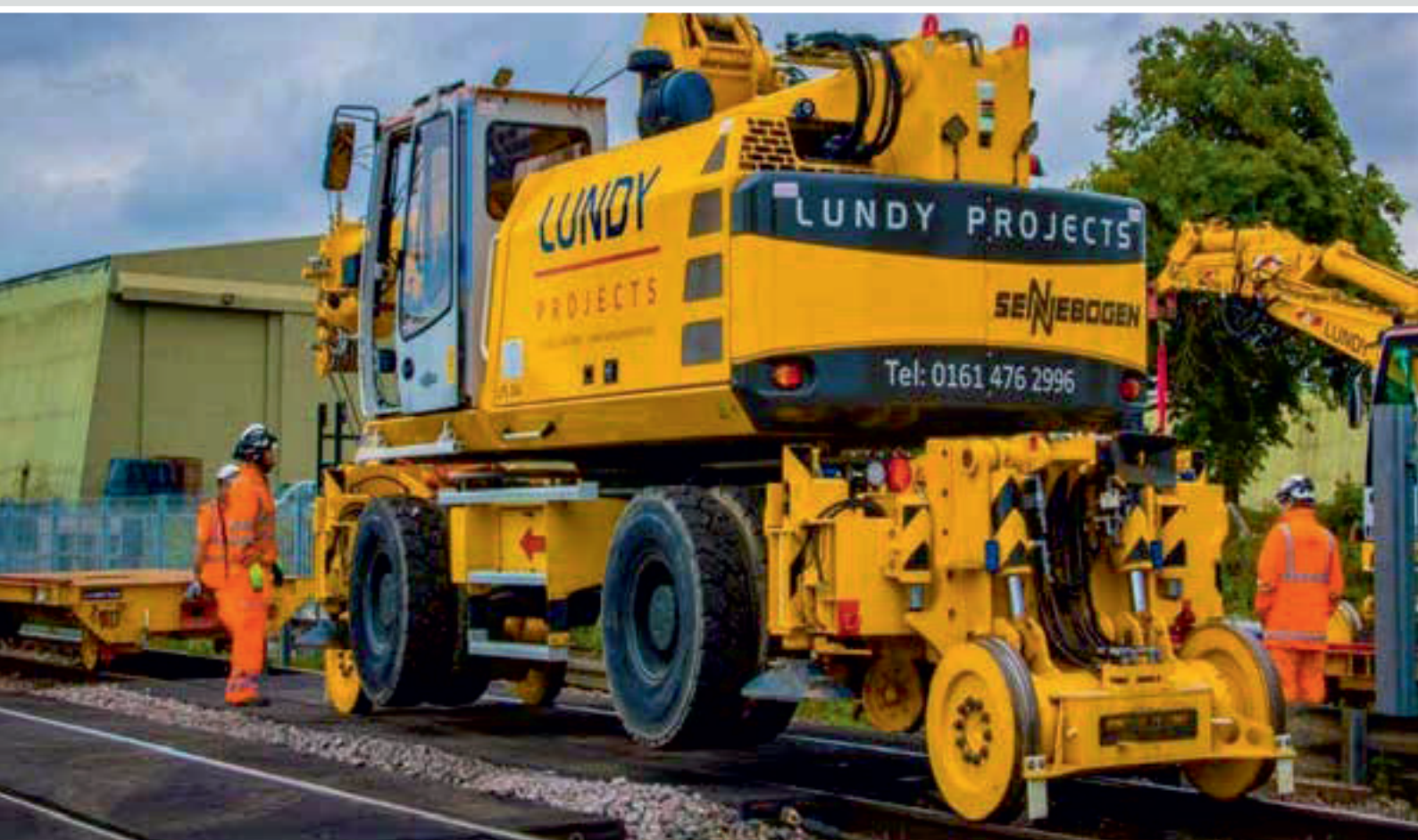
643 M - rail crane 643 M - Schienenkran
